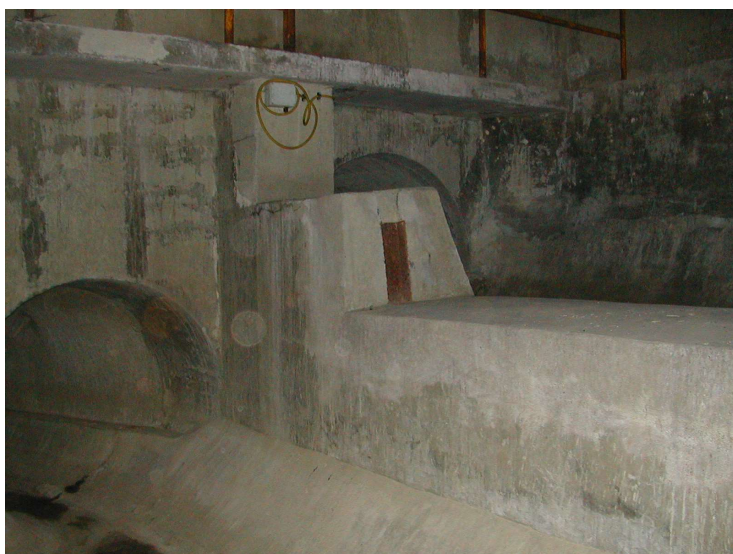
Obr. 4. Odlehčovací hrana
